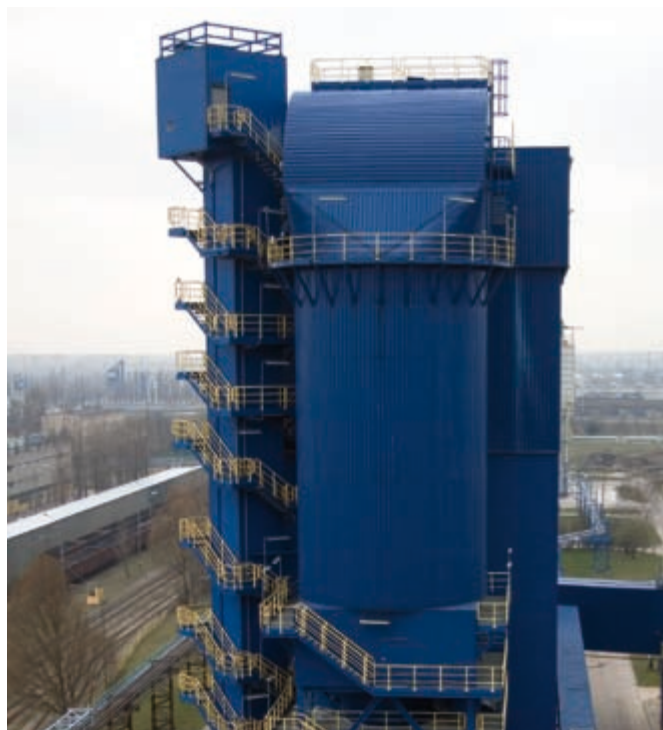
Instalacja IOS fot. DALKIA
