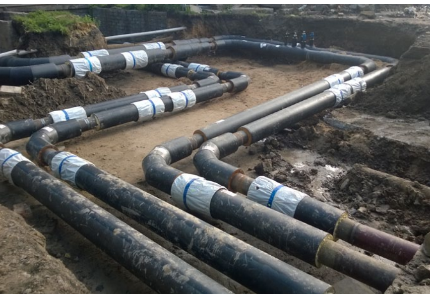
Remont sieci ciepłowniczej przy ul. Wróblewskiego
